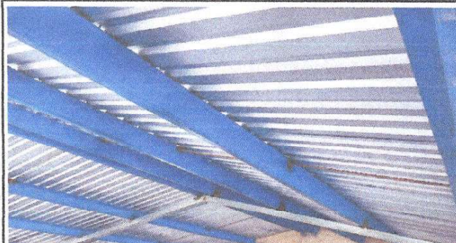
Foto 2: Sustitución de estructura de metal por metal
