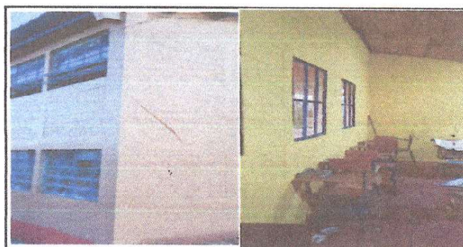
Foto 6: Pintura en muros exteriores e interiores
