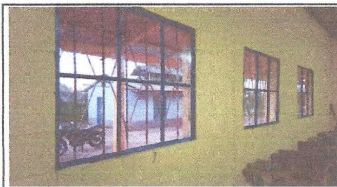
Foto 3: Sustitución de ventana de madera por metal
