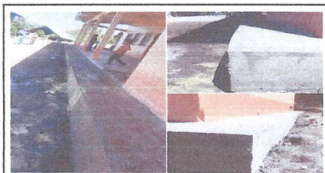
Foto 5: Reparación de banquetas de concreto
