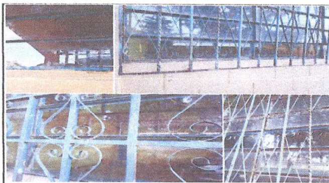
Foto 4: Sustitución de vidrios
